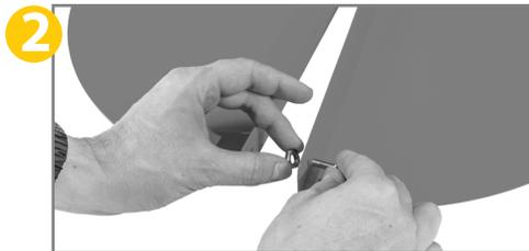
Inbusschraube durch beide Löcher schieben; dazwischen Mutter als Abstandshalter positionieren
