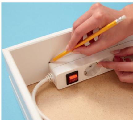
**Lege** die Steckdosenleiste in die Schublade, um an deren Rückseite den Platz für das Kabelloch abzumessen und anzuzeichnen.
