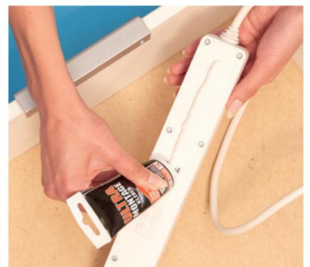
**Führe** das Kabel der Steckdosenleiste durch das Loch, bestreibe sie mit Klebstoff ...
