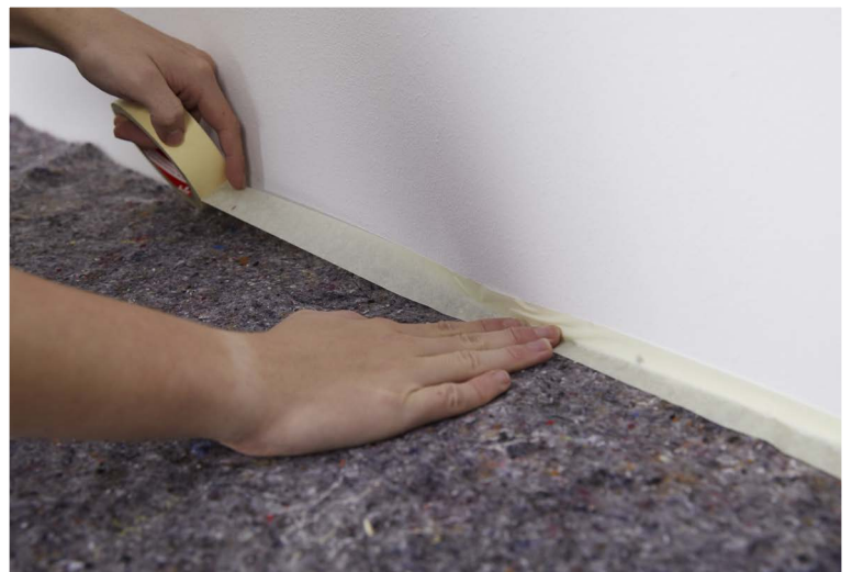
Klebe die Fußbodenleiste sorgfältig mit Abklebeband ab, und sichere auch den Fußboden mit Folie oder Malervlies.
