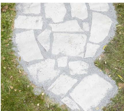
Verlege nun die **Natursteinplatten** auf dem Sand mit jeweils 5 bis 10 cm Abstand, damit das Muster gut erkennbar ist. Wenn alle Platten liegen, werden diese mit einem Gummihammer festgeklopft. Fülle die Zwischenräume mit dem übrigen Kies auf, der gleichzeitig als Drainage für die Dusche dient.
