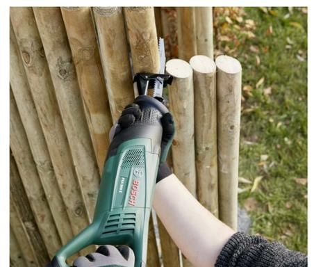
Auf zum schwungvollen Abschluss: Mit der **Säbelsäge** werden die oberen Enden der Zaunpfähle so gekürzt, dass zum Eingang hin ein abfallender Bogen entsteht.
