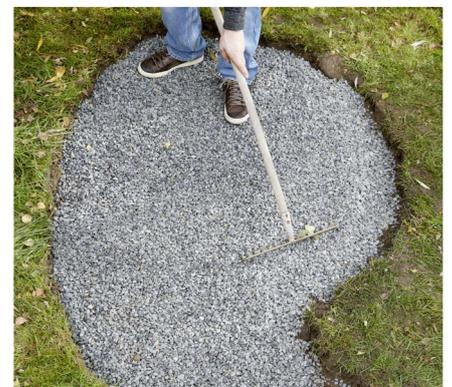
Verteile den **Kies** mit einem Rechen gleichmäßig innerhalb der ausgehobenen Fläche. Darauf wiederum verteilst du den Sand und streichst ihn mit einer Holzleiste o.a. glatt. Der Sand stellt sicher, dass später alle Platten eben aufliegen.
