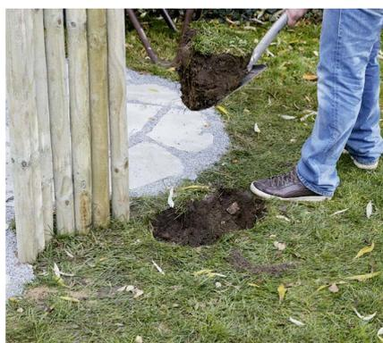
Schlage die **Zaunpfähle** dicht an dicht mit einem Vorschlaghammer ca. 50 cm tief in den Boden. Spare dabei den Duscheingang (ca. 1,5 m) aus. Für eine natürlichere Optik kannst du zwei weitere Stellen von ca. 30 cm aussparen, hier ca. 20 cm Erde ausheben und je 3–4 Hainbuchen einpflanzen, die blickdicht zuwachsen.
