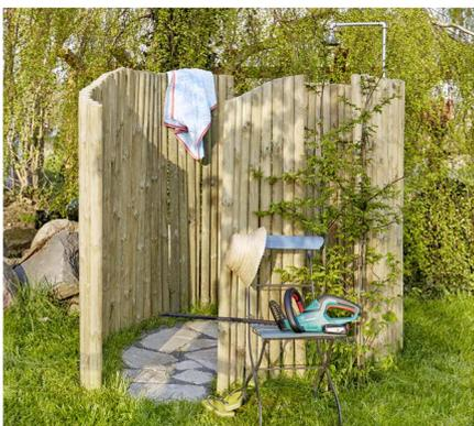
Bestimme zunächst die **Form** der Gartendusche, indem du mit den Natursteinplatten den Boden auslegst. Anschließend stichst du mit dem Spaten den Umriss rings um die Platten ein. Achte darauf, dass später ausreichend Platz zum Duschen und der Eingang groß genug ist.
