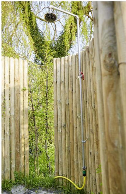
Bevor du dich abkühlen kannst, musst du noch den **Wasseranschluss** gemäß Herstellerangaben verlegen. Anschließend wird die Duschhalterung an einem Pfahl festgeschraubt und der Schlauch an die Dusche angeschlossen. Und nun heißt es: Wasser marsch!
