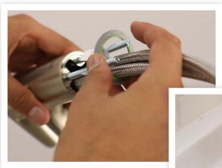
An der Unterseite des Armaturegehäuses wird eine Gummidichtung aufgesteckt, und die flexiblen Anschlusschläuche werden von oben durch die Bohrung (das Hahnloch) im Tisch bzw. im Waschbecken geführt.
