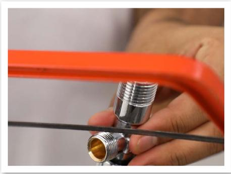
Zum Abdichten des Eckventils wird das Gewinde aufgeraut, indem du mit einem Sägeblatt quer zur Sägerichtung über das Gewinde fährst.
