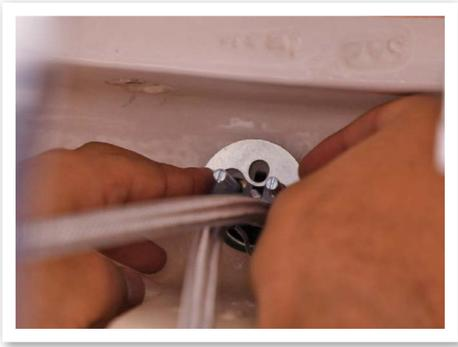
Von der Unterseite wird nun zum Fixieren der Armatur die halbmond-förmige Unterlegscheibe mit der Dichtscheibe auf den Gewindebolzen aufgesteckt und mit der beiliegenden Mutter handfest verschraubt. Nun wird die Armatur von oben nochmals ausgerichtet. Anschließend wird die Mutter mit einem Maul- oder Steckschlüssel von unten vorsichtig festgeschraubt.
