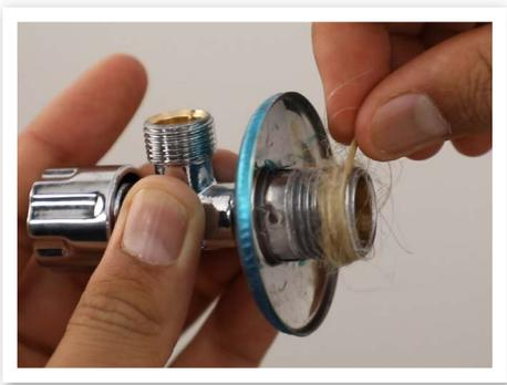
Dann wird der Dichtungshanf um das Gewinde gewickelt und anschließend mit Dichtungspaste bestrichen, damit der Hanf am Gewinde hält, wenn das Eckventil eingedreht wird.
