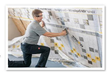
in ca. 10 cm überlappenden Bahnen. Verklebe die Folienstöße mit **Klebeband.** Schlage die Folie nach innen um und ziehe entlang der Abschlusskante an den Firstenden mit Silikonspritze und **Dichtmasse** eine ca. 0,8 cm starke Linie. Schlage dann die Dampfsperre wieder zurück, drücke den Kleber mit den Fingern fest und schneide nach dem Trocknen die überstehende Folie ab.
