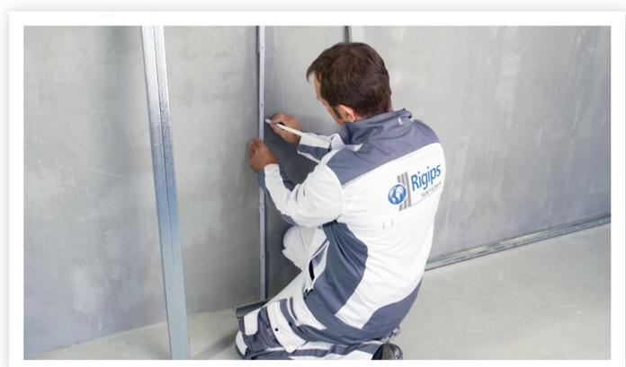
renzpunkt und zeichne mit einer Wasserwaage den Verlauf der Senkrechten an den Seitenwänden sowie auf Boden und Decke genau an. Als Leitlinie kann dir dabei eine Schlagschnur dienen, die du straff von Seitenwand zu Seitenwand ziehst.
