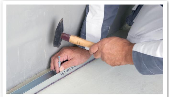
Sind beide UW-Profilstrecken angebracht, werden die seitlichen **CW-Profile als Rahmen für das Trockenbau-Ständerwerk** an die Flügelwände montiert. Gehe wieder wie oben beschrieben vor: Profil anhalten, Bohrpositionen markieren, bohren, Dübel einsetzen.
