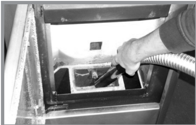
Abb. 12f: Reinigung Brennraumbehälter
