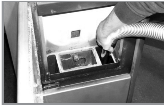
Abb. 12g: Reinigung untere Brennkammer
