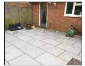
Stellen Sie sicher, dass Sie einen ebenen Betonsockel, eine ordnungsgemäß angebrachte Holzterrasse oder stabiles Verbundpflaster mit Zugang zu einem Abfluss vorbereitet haben.
