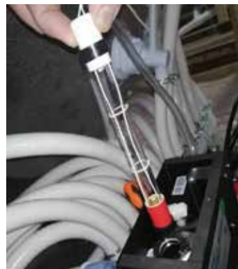
5. Schritt: UV Licht zum Wechsels rausnehmen
