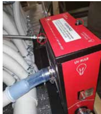
1. Schritt: Die zwei mit rot markierten Schrauben rausdrehen
