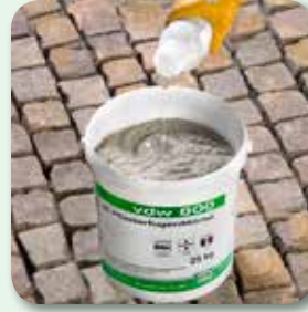
Bindemittelkomponente zugeben
