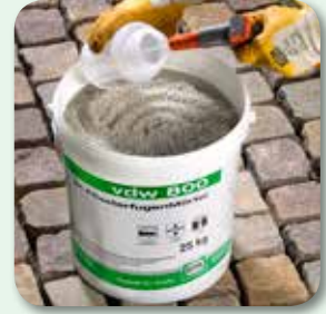
max. die doppelte Menge an Wasser zugeben
