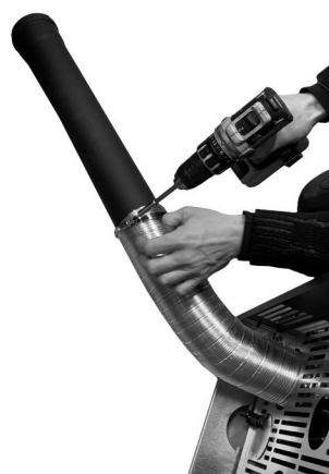
Fig. 61 - Rohr D. 80 mm anschließen
