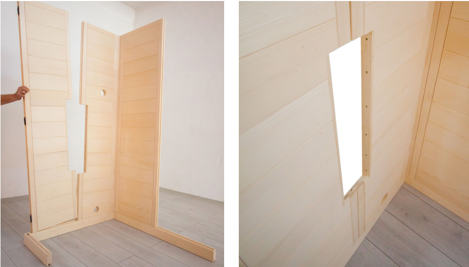
Abb. 6: Wandelement mit Ausschnitt einsetzen
