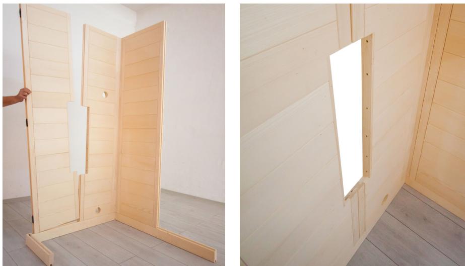
Fig. 6 : Insérer l'élément mural avec la découpe
