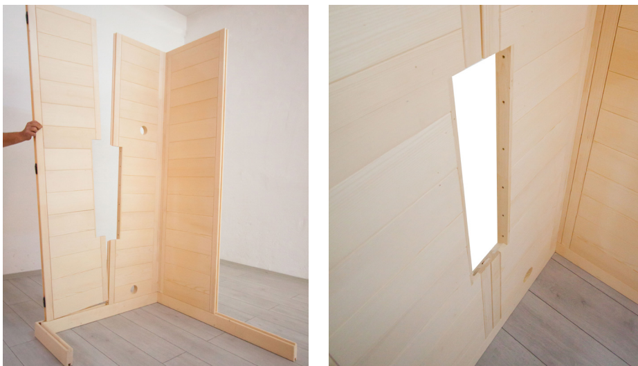
Fig. 6: Instalar o elemento de parede com abertura
