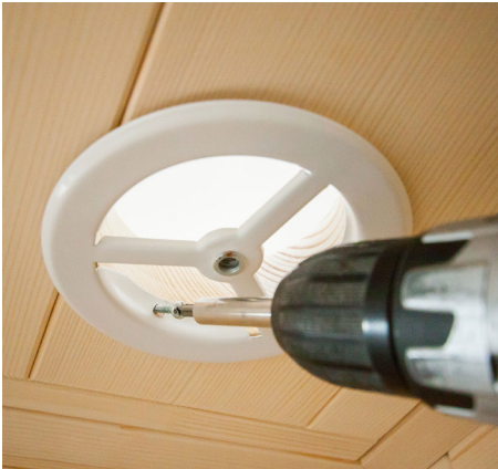
Fig. 17 : Montage de la ventilation
