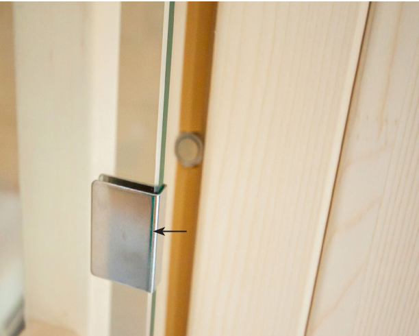
Abb. 35: Montage Überschub-Blech
