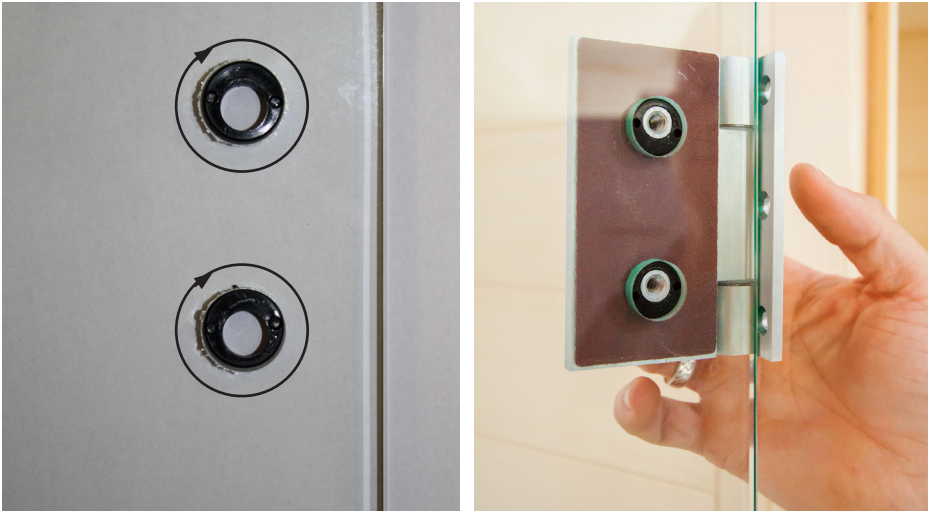
Fig. 31: Installing door fittings 1
