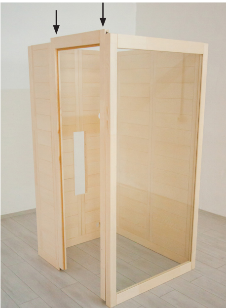
Abb. 10: Montage des Türrahmens
