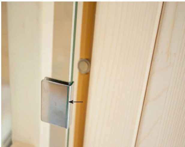
Fig. 35: Montagem da chapa de transferência
