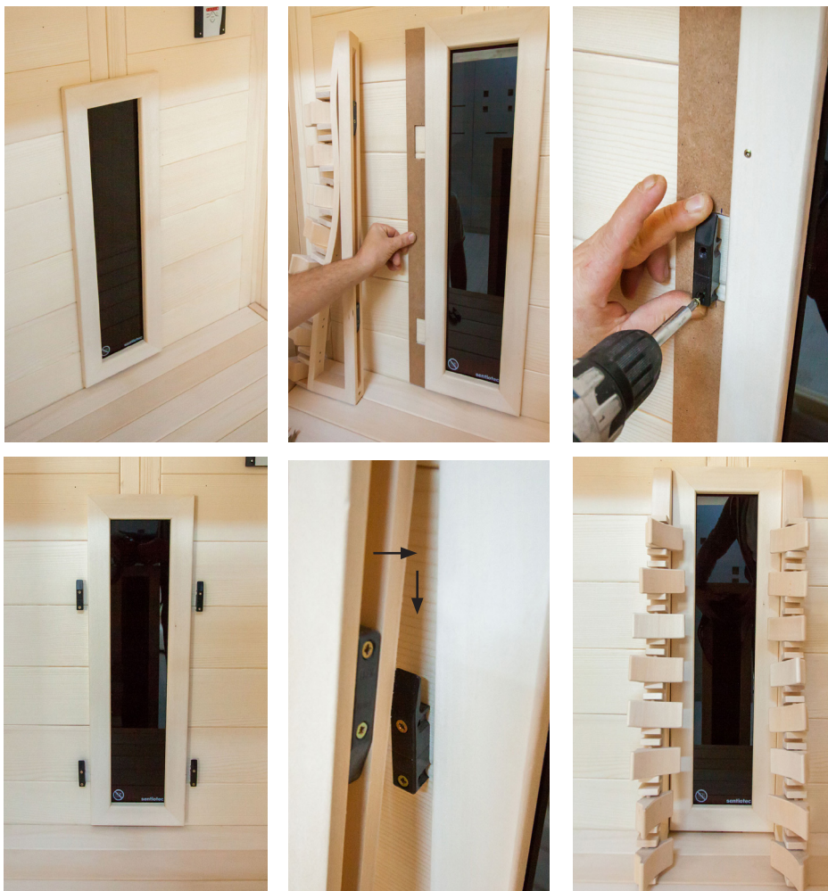
Fig. 29: Montagem dos encostos
