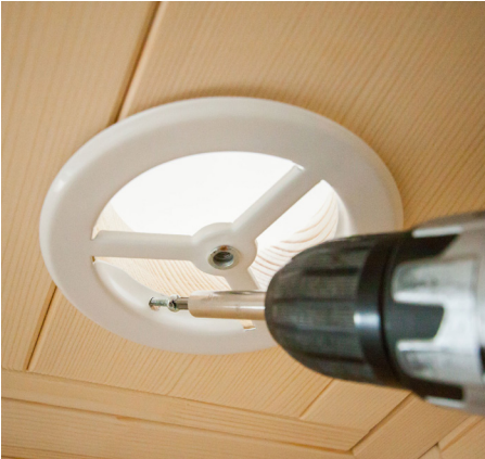
Afb. 17: Montage van de ontluchting
