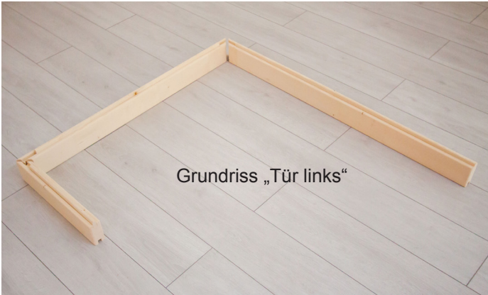
Abb. 1: Auflegen der drei Bodenrahmen-Elemente
