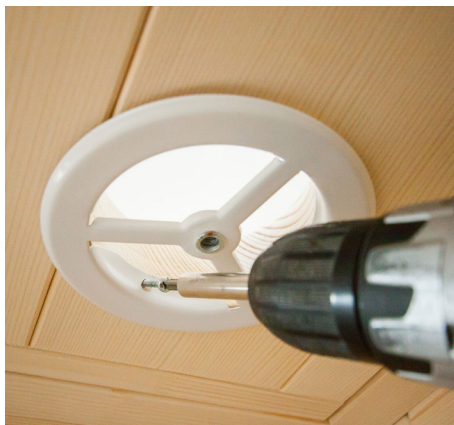
Fig. 17: Montagem da ventilação
