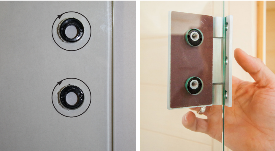
Fig. 31 : Montage des ferrures de portes 1
