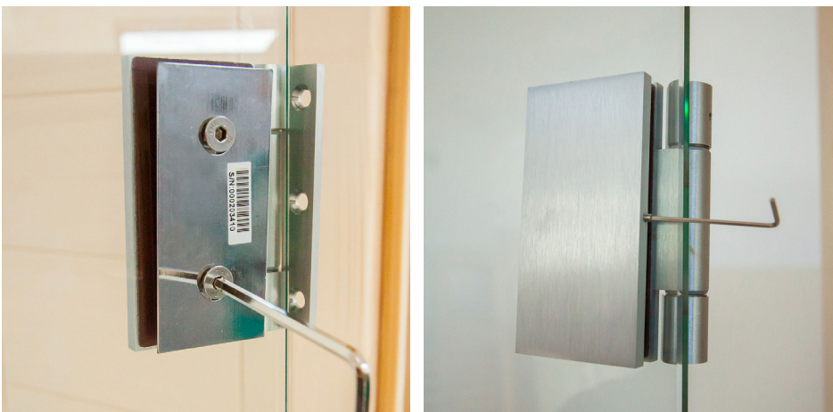
Fig. 32: Montagem das ferragens da porta 2
