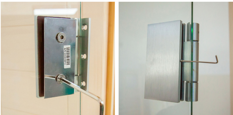
Abb. 32: Montage Türbeschläge 2
