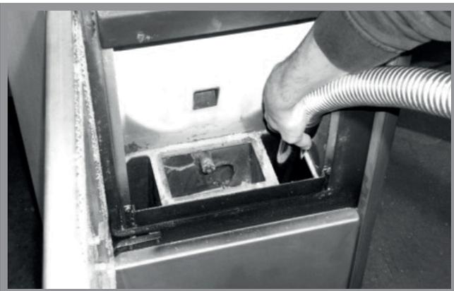
Abb. 12g: Reinigung untere Brennkammer
