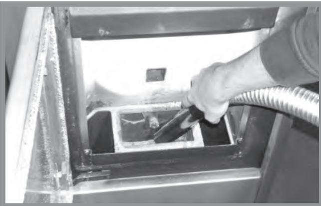
Abb. 12f: Reinigung Brennraumbehälter
