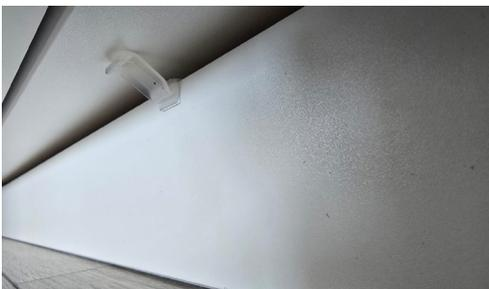
4. Zur Demontage des Sockels schieben Sie die Sockelbefestigung einfach zur Seite, bis der Widerstand gelöst ist. Dadurch können Sie die Sockelleiste nach vorne ziehen.
