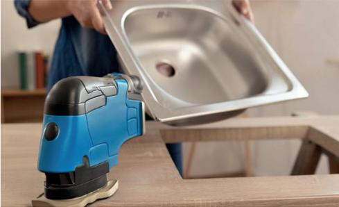
1. Legen Sie die Arbeitsplatte mit der Oberseite auf eine feste Unterlage und zeichnen Sie dann den Ausschnitt auf der Rückseite an.
