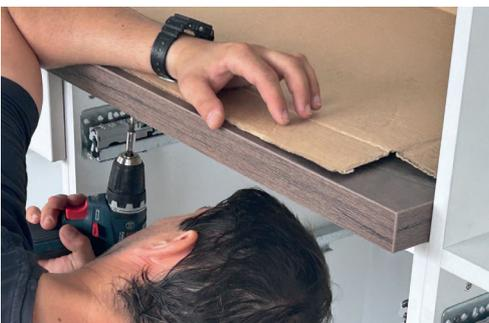
4. Bevor Sie die Arbeitsplatte verschrauben, prüfen Sie zunächst den Arbeitsplattenüberstand. ( 40 mm )
