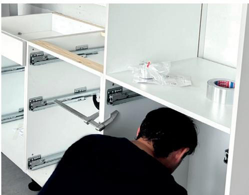
1. Stellen Sie die Unterschränke nebeneinander auf und entfernen Sie die Fronten und Auzüge. Legen Sie nun eine Wasserwaage auf die Traverleiste (obere Schrankkante). Richten Sie die Unterschränke in **beide** Richtungen mit der Wasserwaage millimetergenau aus.
