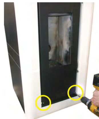
Fig. 38 - Befestigung Rahmen
