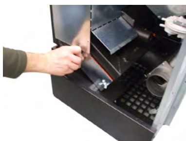
Fig. 79 - Rauchgaskammer
