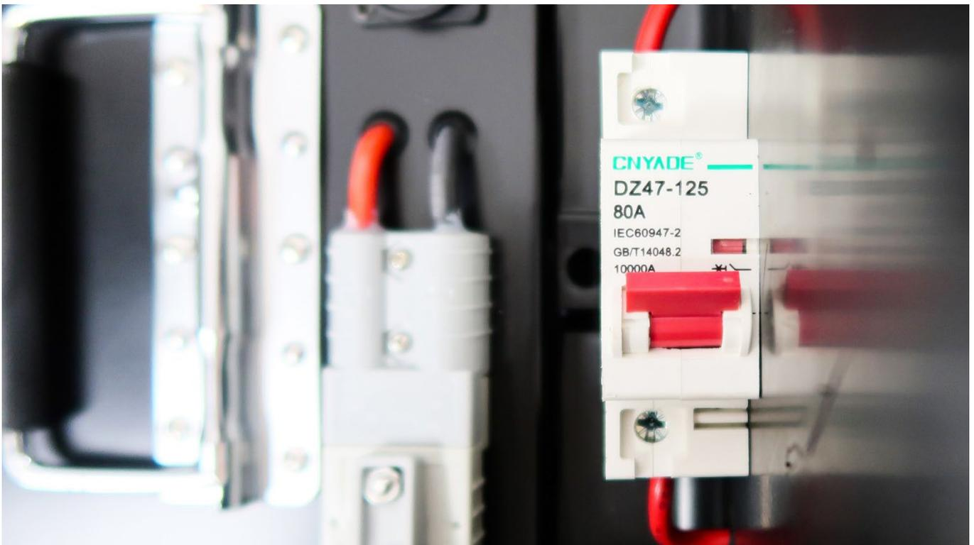
Die Hauptsicherung ist eingeschaltet: Das Kästchen über dem Schalter ist rot markiert und signalisiert: Aufpassen - Strom fließt!
