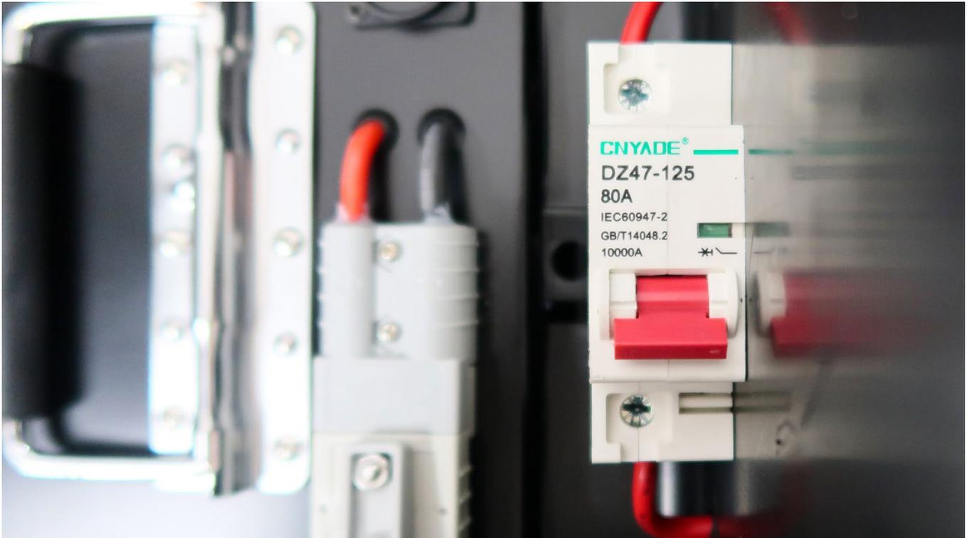
Die Hauptsicherung ist ausgeschaltet: Das Kästchen über dem Schalter ist grün markiert und signalisiert: Es ist sicher - kein fließender Strom.
