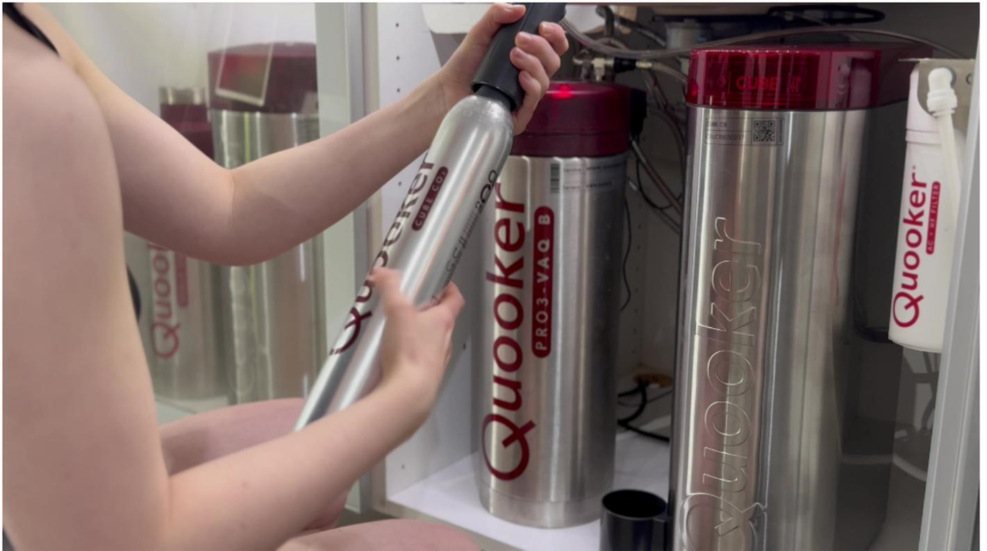
Montage mittels beiliegendem Aufschraubadapter und Dichtung zur Verwendung des Quooker Cube.
