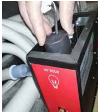
6. Schritt: Neues UV Licht in die Metallröhre stecken und schwarze Abdeckung wieder plazieren
