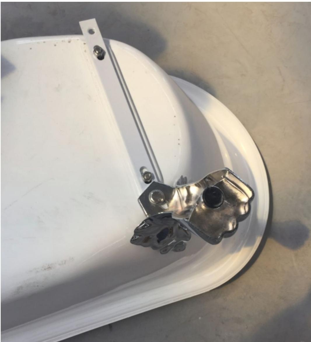
Auch bei der **Badewanne Veldi** werden zunächst die Schienen an der Wanne befestigt, an denen im nächsten Schritt die FüÙe angebracht werden.
