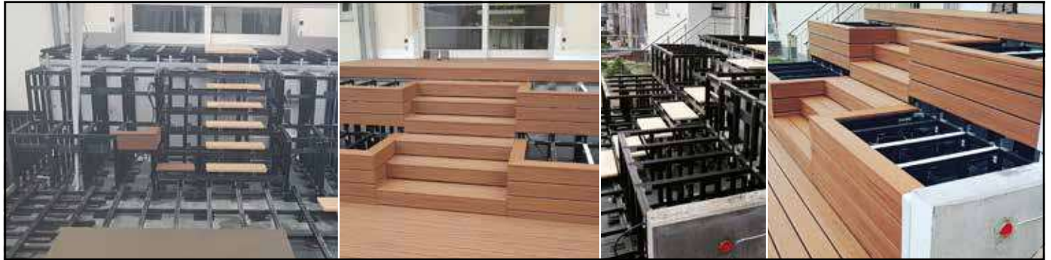
Stufenausbildung Kombination Unterkonstruktions- und Konstruktionsprofil
