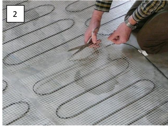
Einschneiden der Heizmatte entsprechend der baulichen Gegebenheiten
