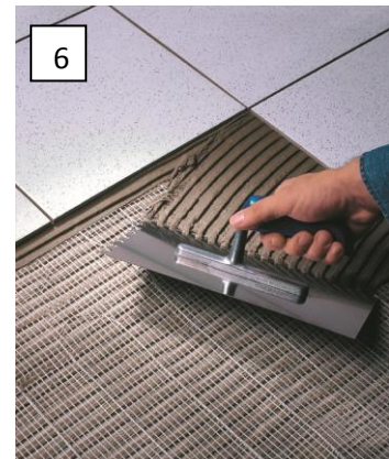
in einem Arbeitsgang Fliesen gleich in Kleber einbetten
