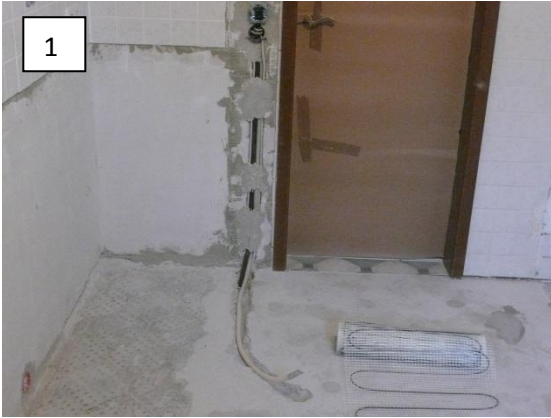
Verlegen des Bodentemperaturfühlers im Leerrohr
