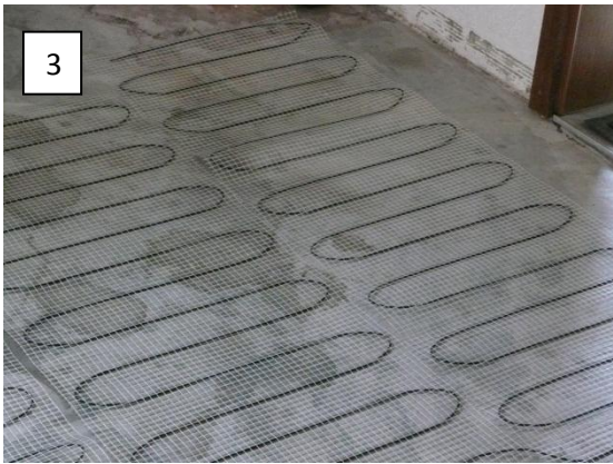
Auslegen der selbstklebenden Heizmatte
