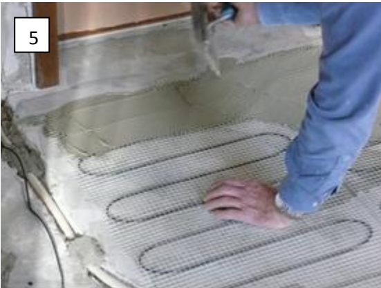
Vollflächiges Verspachteln mit Flex-Kleber, Auftragen des Fliesenklebers und Verlegen der Fliesen
