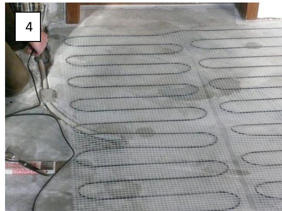
Kaltleiter neben der Matte zum Anschlusspunkt führen
