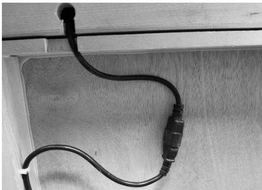
(1) Stecken Sie die Stecker der Heizkabel ein, (stellen Sie sicher, dass die Kabel nicht eingeklemmt werden zwischen Deckenpaneel und anderen Paneelen eingeklemmt werden.
