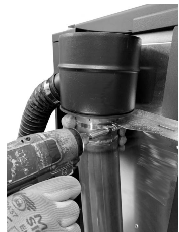
Fig. 48 - Mit Schelle sichern
