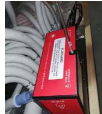
8. Schritt: Rote Abdeckung wieder festschrauben
