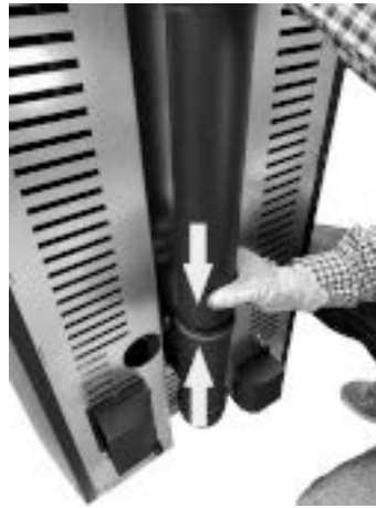
Fig. 47 - Die Rohre anschließen
