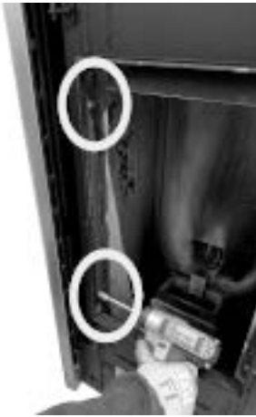
Fig. 76 - Die Sechskantschrauben entfernen
