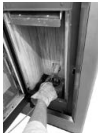
Fig. 36 - Reinigung mit Flaschenbürste
