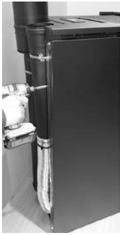
Fig. 29 - Hintere Schrauben entfernen
