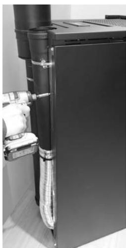
Fig. 19 - Hintere Schrauben abschrauben
