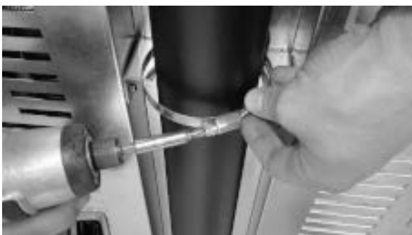
Fig. 52 - Mit Schellen fixieren
