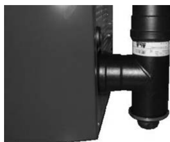
Fig. 75 - Reinigung des Rauchgaskanals
