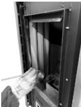
Fig. 81 - Mit einer Rohrreinigungsbürste reinigen
