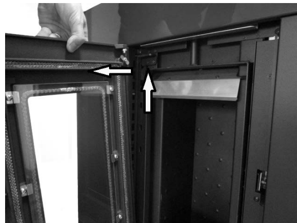
Fig. 18 - Ausbau der Tür
