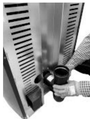
Fig. 45 - T-Anschlussstück anschließen
