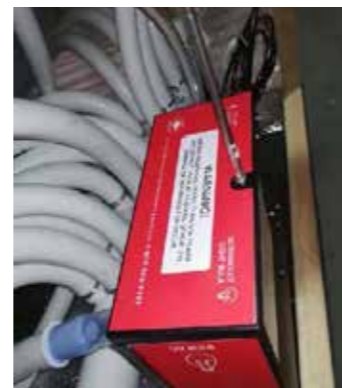
8. Schritt: Rote Abdeckung wieder festschrauben
