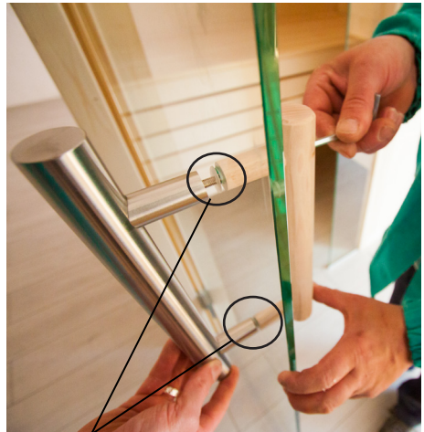
Kunststoff Beilagscheibe bei Niro-Griff beilegen
