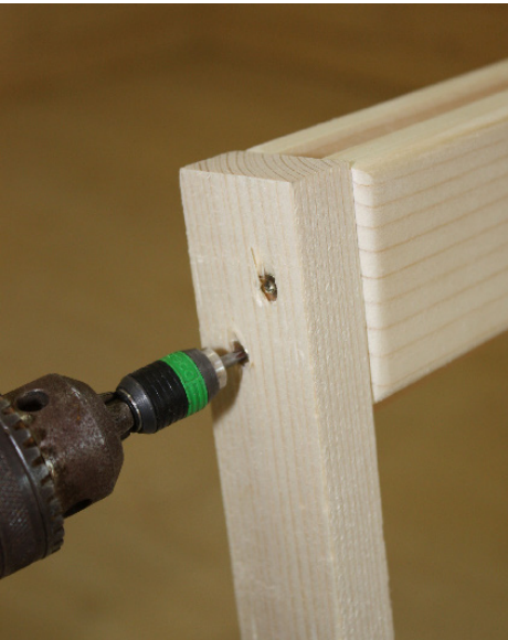
Transportleiste vom Türstock entfernen
