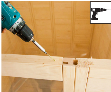
Bohrer 3 mm, 1 Stk. Schrauben 4 x 70 mm
