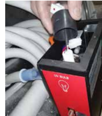
4. Schritt: Schwarze Abdeckung herausnehmen
