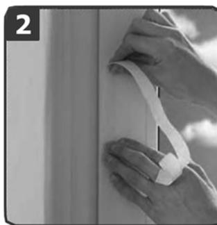
**B:** Úzkou stranu těsnění vždy připevňte ke křídlu okna. Úzkou stranu tesnenia vždy pripievňte ku křídlu okna. Always attach the narrow sealing side to the casement. A tömítés keskeny oldalát mindig az ablakszárnyhoz rögzítse. Wąską stronę uszczelki zawsze umocować do skrzydła okna. Schmale Seite der Dichtung immer an den Fensterflügel befestigen.
