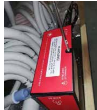
8. Schritt: Rote Abdeckung wieder festschrauben
