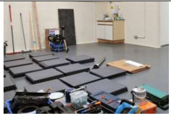
Bild Nr. 1 Gliedern Sie bitte die Palette auf um den Akklimatisationsprozess zu beschleunigen
