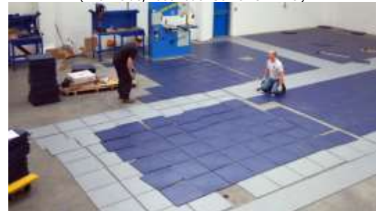
Bild Nr. 4 Gliedern Sie bitte die Palette auf und verlegen Sie die Fliesen lose, bevor Sie mit dem Fixieren anfangen
