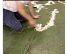
Bild Nr. 2 Kehren Sie bitte den Boden und entfernen bzw. reparieren alle Unebenheiten
