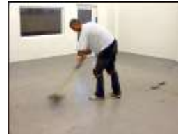
Bild Nr. 2 Kehren Sie bitte den Boden und entfernen bzw. reparieren alle Unebenheiten
