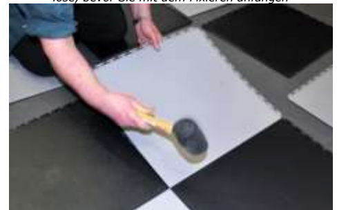
Bild Nr. 5 Beginnend von einer Ecke, mit wenig Druck zwei Fliesen mit Gummihammer klopfend, kreisförmig verbinden
