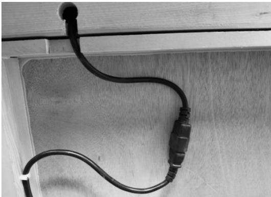
(1) Stecken Sie die Stecker der Heizkabel ein. Stellen Sie sicher, dass die Kabel nicht zwischen den Platten eingeklemmt werden.
