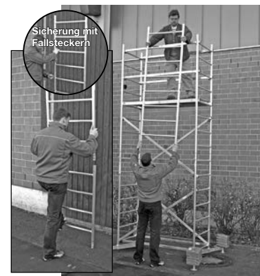
Grundgerüst mit erster und zweiter Aufstockung
