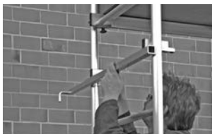
Grundgerüst mit erster Aufstockung
