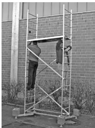
Grundgerüst mit erster und zweiter Aufstockung
