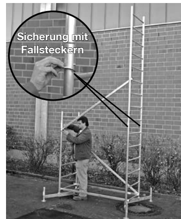
Grundgerüst mit erster Aufstockung
