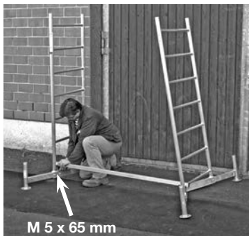
Grundgerüst mit erster Aufstockung
