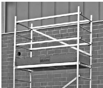
Grundgerüst mit erster Aufstockung
