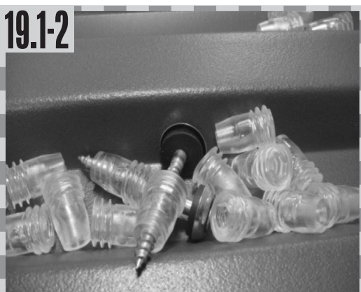
19.1-2 Abstandshalter und Schrauben auf der Bedachungsplatte ablegen
