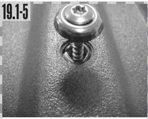
19.1-5 Spenglerschraube setzen...
