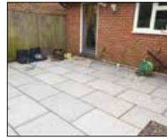
Stellen Sie sicher, dass Sie einen ebenen Betonsockel, eine ordnungsgemäß angebrachte Holzterrasse oder stabiles Verbundpflaster mit Zugang zu einem Abfluss vorbereitet haben.
