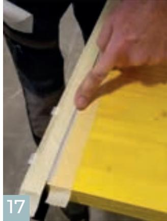
17 Die Dichtstoffnaht glätten, um eine gleichmäßige Dichtung zu schaffen.
