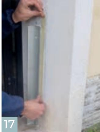
17 Mit Kreppband die Wand entlang des Winkels mit einem Spalt von ca. 5 mm abkleben.
