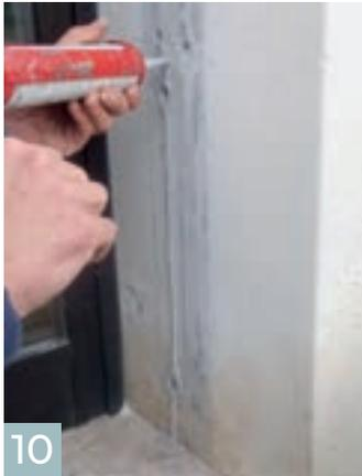
10 Im Bereich der Montagefläche Dichtstoff auftragen.
