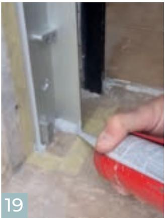
19 Eine Dichtstoffraupe am Fuß des Eckwinkels setzen.
