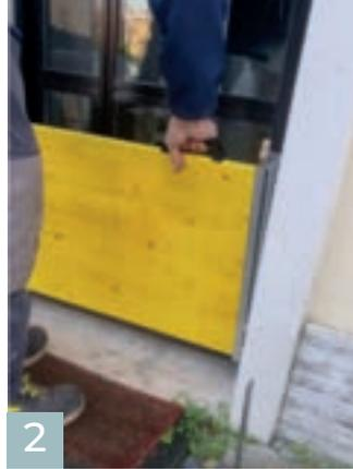
2 Die Wasserschutzwand in die Öffnung einsetzen.
