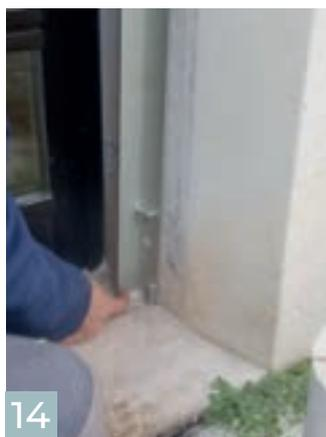
14 Den überschüssigen Dichtstoff entfernen
