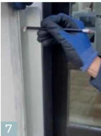
7 Die Position der Bohrlöcher an der Wand markieren.
