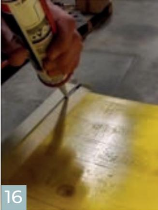
16 Eine Dichtstoffnaht in die Ecke zwischen dem Seitenwinkel und der Schaltafel auf der Seite gegenüber der Dichtung auftragen.
