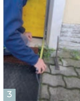
3 Die Wasserschutzwand in der gewünschten Lage positionieren.
