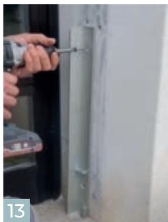
13 Die Eckwinkel an der Wand anschrauben.
