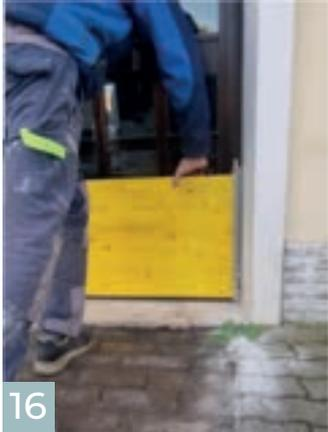
16 Die Montageposition der Wasserschutzwand prüfen.
