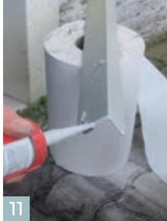
11 An der Rückseite der Nieten und dem Rand, der auf dem Boden aufsteht, mit Dichtstoff abdichten.
