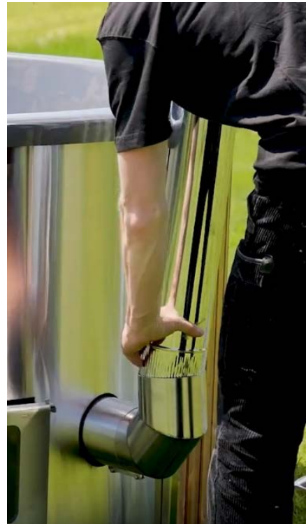
Abbildung 15: Montage des unteren Rohres
