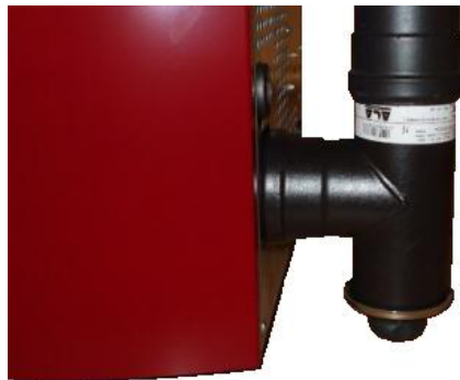
Fig. 97 - Reinigung des Rauchgaskanals
