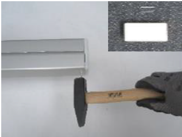
Montage Pfostenverschlusskappe quadratischer Pfosten
