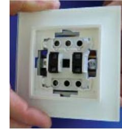
Einsatz mit den ersten beiden Nasen einsetzen und die anderen beiden Nasen eindrücken bis diese hörbar einrasten.
