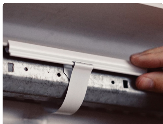
6. Befestigungsfedern justieren
