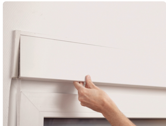
8. Rollladenkasten schließen
