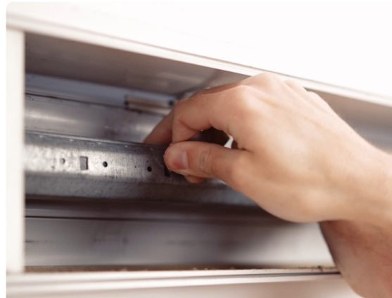
2. Befestigungsfedern aushängen
