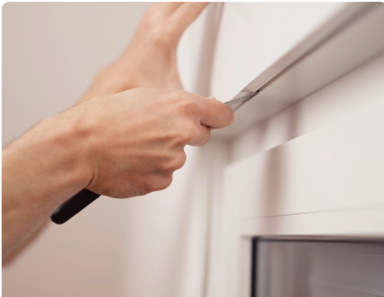
1. Rollladenkasten öffnen
