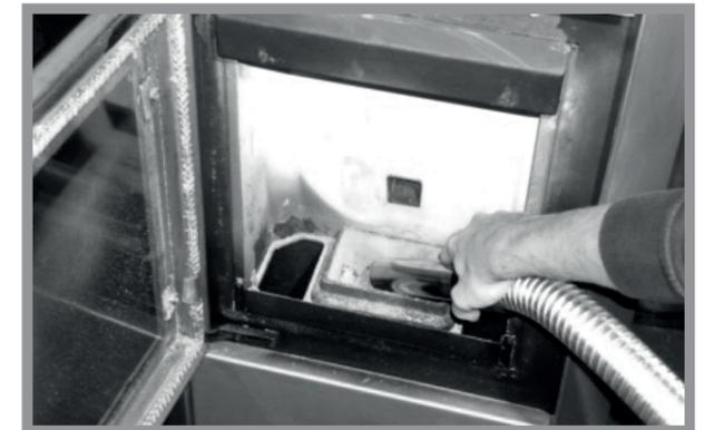
2. Entnehmen Sie dann den Brenntopf. Überprüfen Sie die Luftöffnungen am Boden und den Wänden des Brenntopfes. Vergewissern Sie sich, dass alle Luftöffnungen weder verstopft noch zugesetzt sind. Saugen Sie den Brenntopf gründlich ab (siehe Abb. 12b). Entfernen Sie hartnäckige Verkrustungen und Blockaden, wenn nötig, mit einem geeigneten Werkzeug (siehe Abb. 12c).
