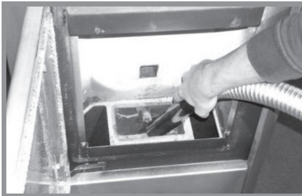
Abb. 12f: Reinigung Brennraumbehälter
