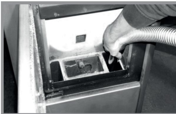
Abb. 12g: Reinigung untere Brennkammer
