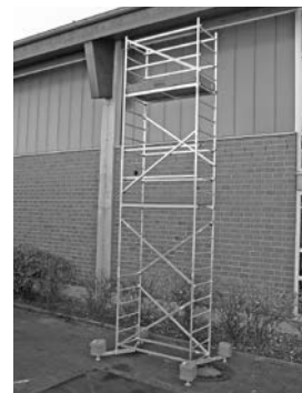
Grundgerüst mit erster und zweiter Aufstockung
