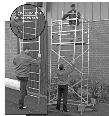
Grundgerüst mit erster und zweiter Aufstockung
