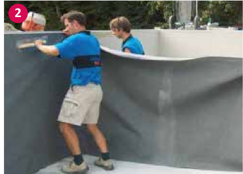
▲ Punktuelle Befestigung der Vliestrennlage mittels Styroporkleber
