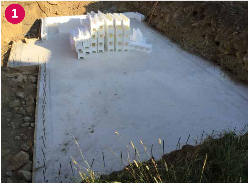
▲ Fertig ausgehärtete Bodenplatte
