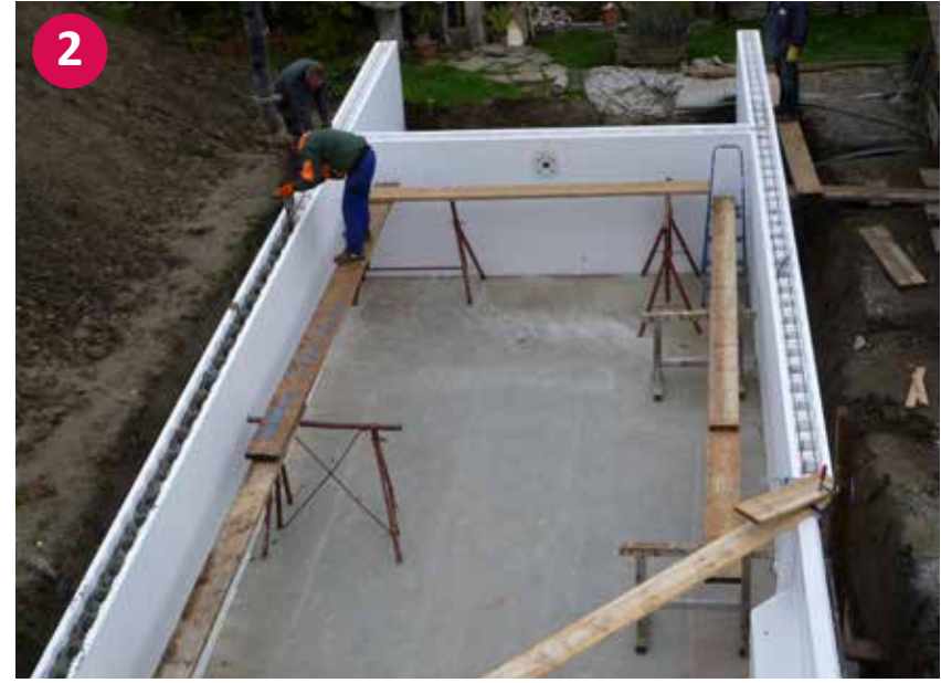
▲ Ausfüllen der Styroporstein mit dem Beton
