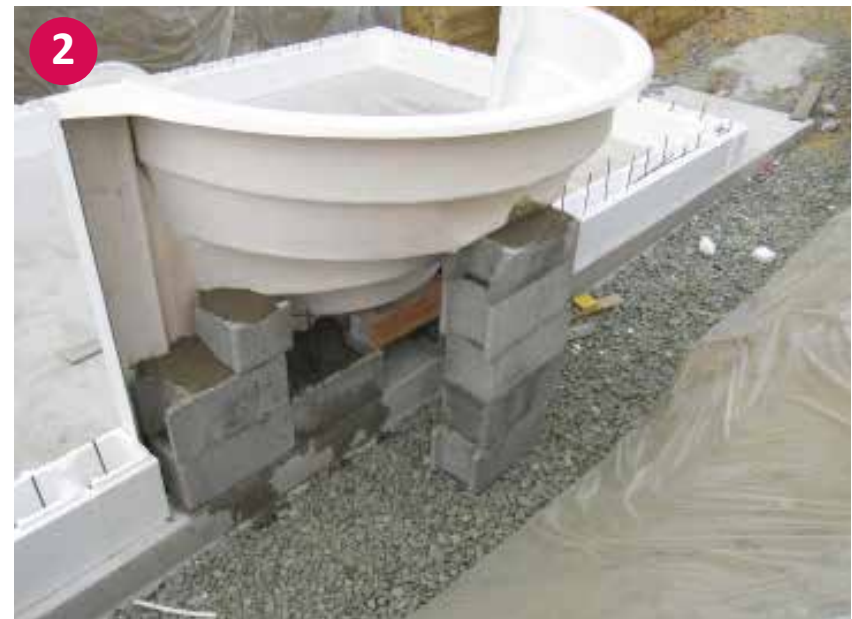
▲ Untermauerung der Römertreppe
