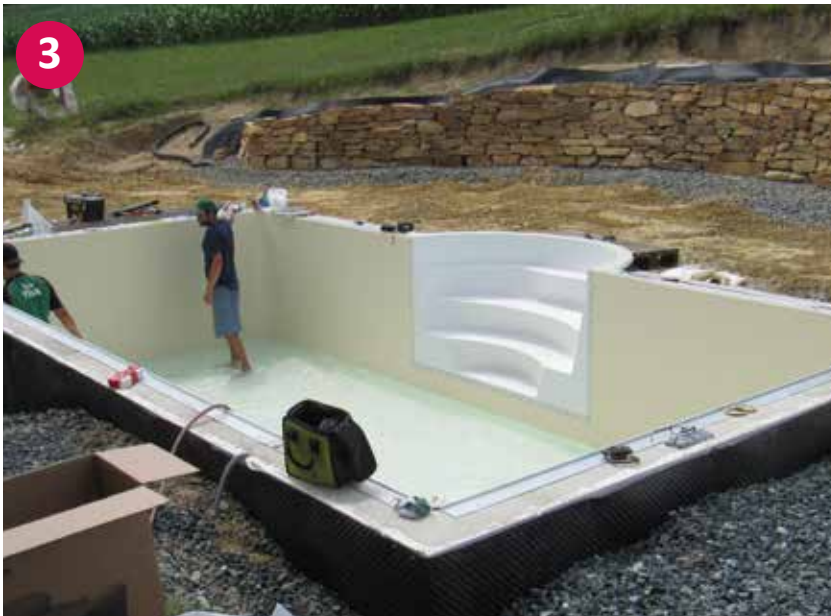
▲ Einhängen des Foliensacks und Anflanschen der Einbauteile
