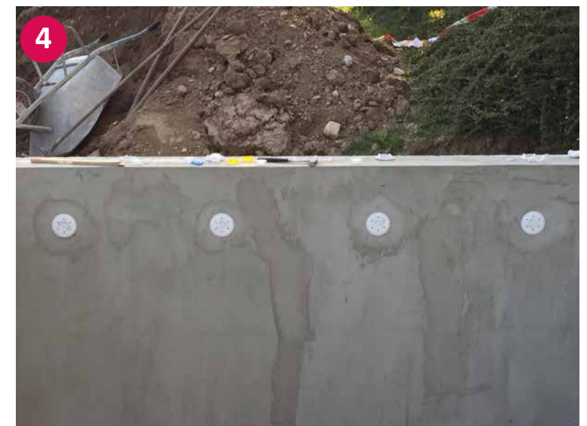
▲ Wichtig: Abdrücken der Rohrleitungen!
