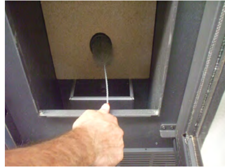
Fig. 59 - Reinigung mit Flaschenbürste
