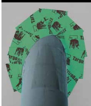
Dunstrohr-Durchdringung schuppenförmig abkleben
