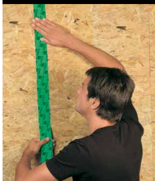
OSB-Platten luftdicht abkleben
