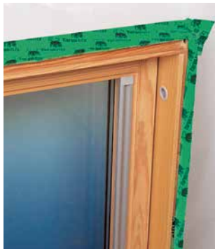
Dachfenster anschliessen
