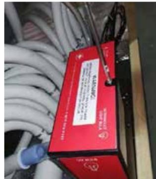
8. Schritt: Rote Abdeckung wieder festschrauben
