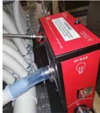
1. Schritt: Lösen Sie die 2 rot markierten Schrauben.
