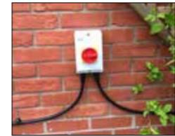
Dreh-Trennschalter (abgebildet). Stellen Sie sicher, dass Sie die Elektrik von einem qualifizierten Elektriker vorbereiten lassen. Lassen Sie 5 Meter Spielraum für den Anschluss an den Whirlpool.
