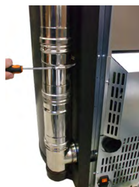
Fig. 83 - Rauchgaskanals (Sfera 3 Plus, Sfera 3 , Globe, Elise 3 Plus)
