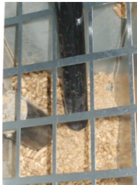
Fig. 60 - Reinigung Tank und Schnecke
