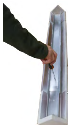
Fig. 26 - Das Profil an den Majoliken anschrauben
