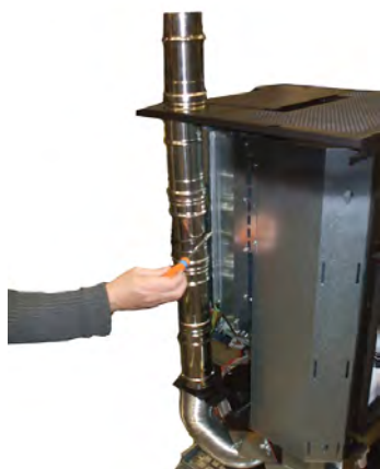
Fig. 45 - Positionierung der Rohre für oberen Kanal
